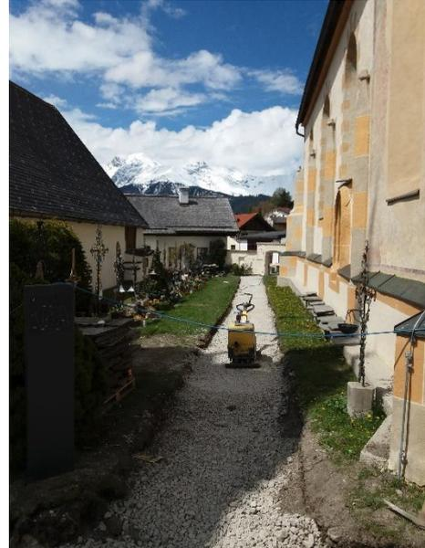
Zunächst mussten die Steinplatten und folglich das Erdreich bis zu einer Tiefe von ca. 60 cm abgetragen werden. Der Aushub wurde mit Frostkoffermaterial aufgefüllt und anschließend eine Schicht aus Kies aufgetragen. Auf ein vorher verlegtes Vlies bzw. aufgetragenem Mörtel wurden schließlich die zum Großteil neuen Natursteinplatten mit viel handwerklichem Geschick zugerichtet und verlegt.
