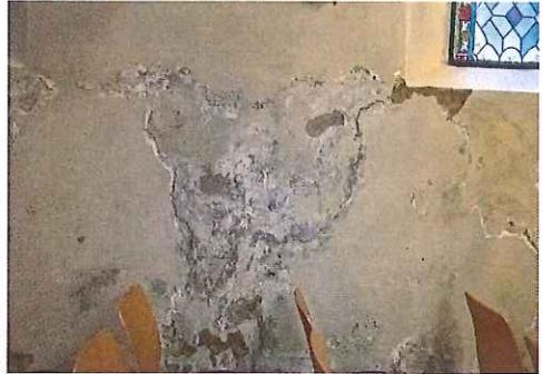
In den kommenden Tagen wird das beschädigte Mauerwerk abgeschlagen und den Winter über offen gelassen. Im Frühjahr wird dann ein temperierbares Spezialnetz angebracht, das verhindern soll, dass wieder Feuchtigkeitsstellen auftreten.
